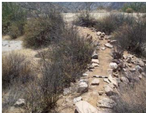
En la foto 13 se observa el muro de división de los reservorios de aproximadamente 1.00 metro de ancho, también se observa cualquier cantidad de piedras que conformaban parte de este muro.
