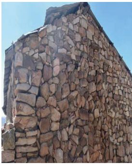
Arquitectura del pueblo de Sumbay
