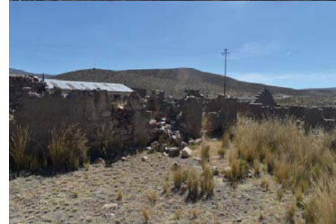
Arquitectura del pueblo de Sumbay
