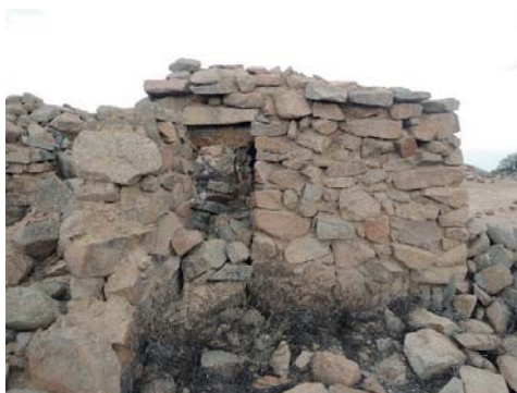
Detalle de los accesos (F29)
