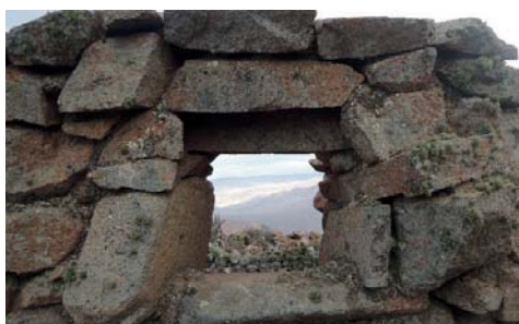
Detalle de las ventana de ventilación (F31)
