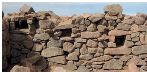
Hornacinas en la pared interna de las estructuras (F12)
