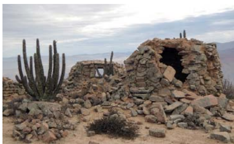
Colcas con ventanas de ventilación (F30)
