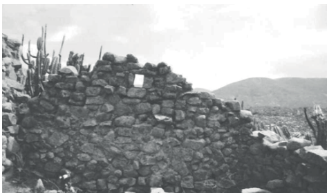
Fig 1 Nótese la forma del muro a dos aguas o hastial con una pequeña ventana.
